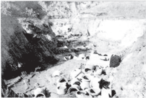
Figura 3: Erosão na atual área do centro poliesportivo, em 1974.
